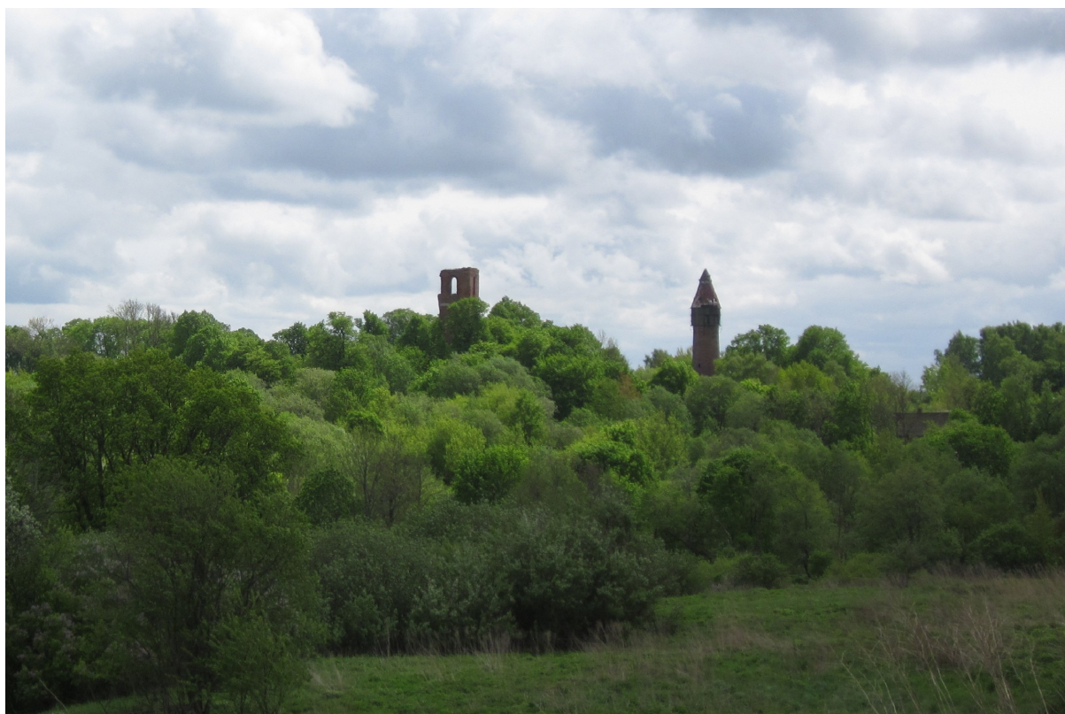
Вид с севера на руины кирхи Св. Барбары и Николая и на водонапорную башню. 2012 г.
