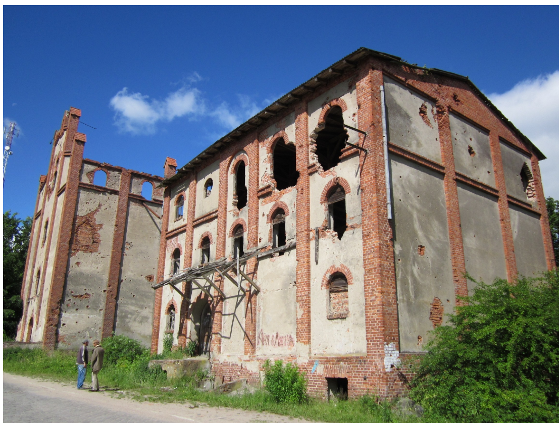
Сохранившееся здание мельницы в Цинтене. Фотография 2011 года.
